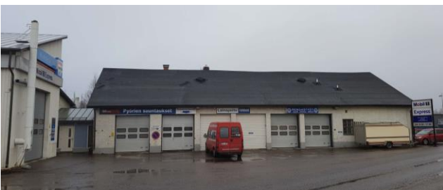
Julkisivu Ratakadulle (pihan puolelle).
