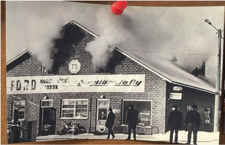
Rakennus on ollut vaarassa tuhoutua tulipalossa. Palon jälkiä näkyy edelleen ullakolla. Kuvassa näkyy päädyn oikeassa laidassa iso näyteikkuna.
