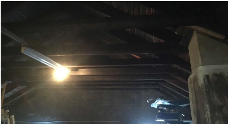
Rakennuksessa on korkea ullakkokerros.
